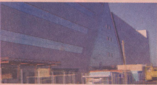
Lavori avanzati. Ultimi ritocchi per Megalopolis Mall nei pressi di Chishinau
